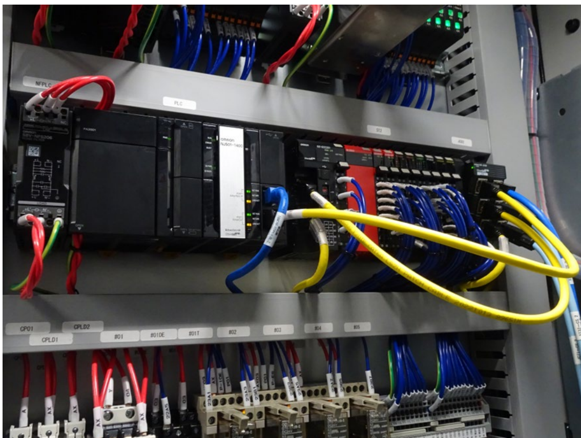
図 5：制御盤内の PLC（中段左・銀色）とセーフティのコントローラ（中段右・赤色）出所）ニューロング工業喜多方工場の了解を得て筆者撮影。
