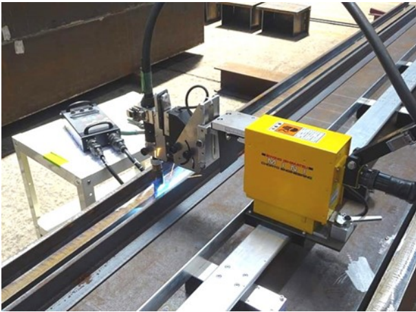
図7 開発技術適用状況 (四面ボックス柱の角溶接)
