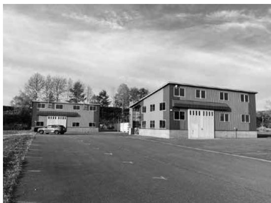
写真 1 ロケットエンジン地上燃焼実験設備
