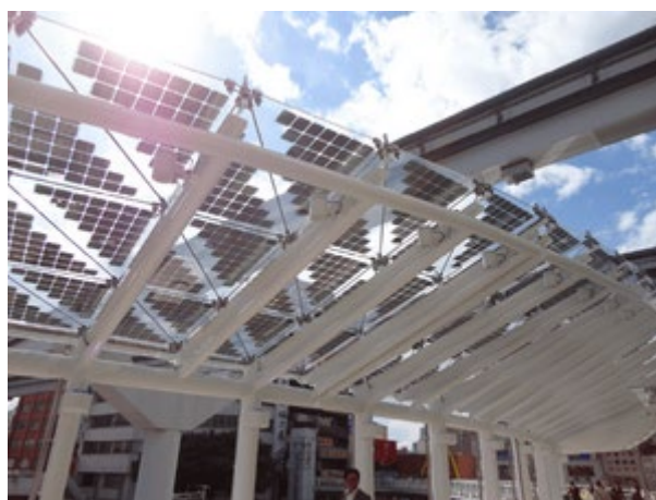
図 5-6 サンジュール®のスクエア（基本タイプ）の採光性を活かした庇の事例 （出典：AGC ウェブサイト、「サンジュール®ラインナップ」） 55
