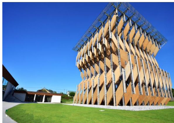
図表 3.2.10 観光施設「GREENable HIRUZEN」(岡山県真庭市)
